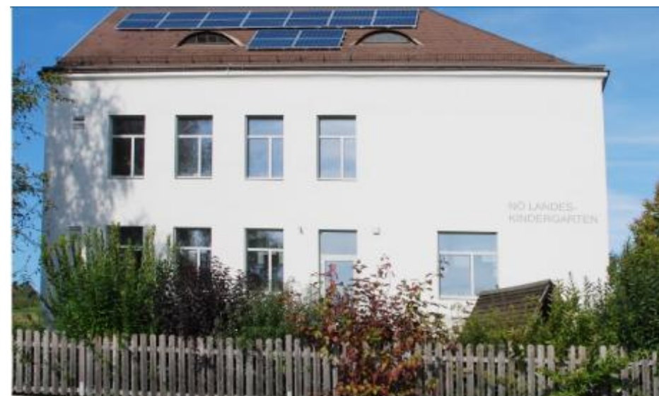
© Ansicht Süd-West, nach Sanierung (AH3 Architekten ZT GmbH, C.OE)
