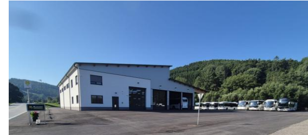
Ladepark Schlatten groß • 600 kW Ladeleistung • 8 Ladepunkte • für 14 Stück LE12m Busse
