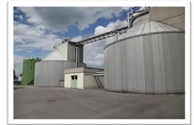
Faultürme der Kläranlage
